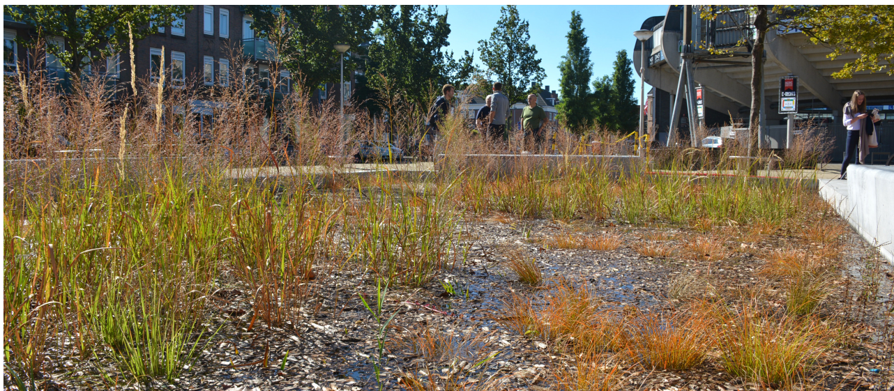
Figuur 3.2 — foto van de Bluebloqs Biofilter bij de Urban Waterbuffer in Spangen. Field Factors, 2018
